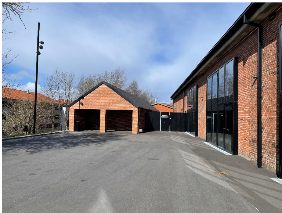
Depotbygning set fra udearealerne ved Gerlachsgade 10, Sønderborg
