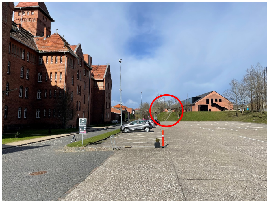
Depotbygning set fra det centrale parkeringsareal i lokalplanområdet.
